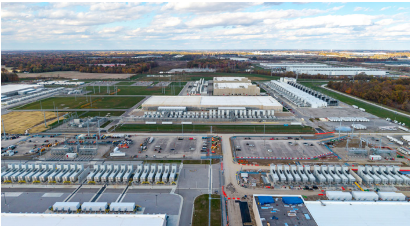
Exemple de data centers nouvelle génération, ici à proximité de Dublin, une ville américaine de 30 000 habitants, dans l'État de l'Ohio.
